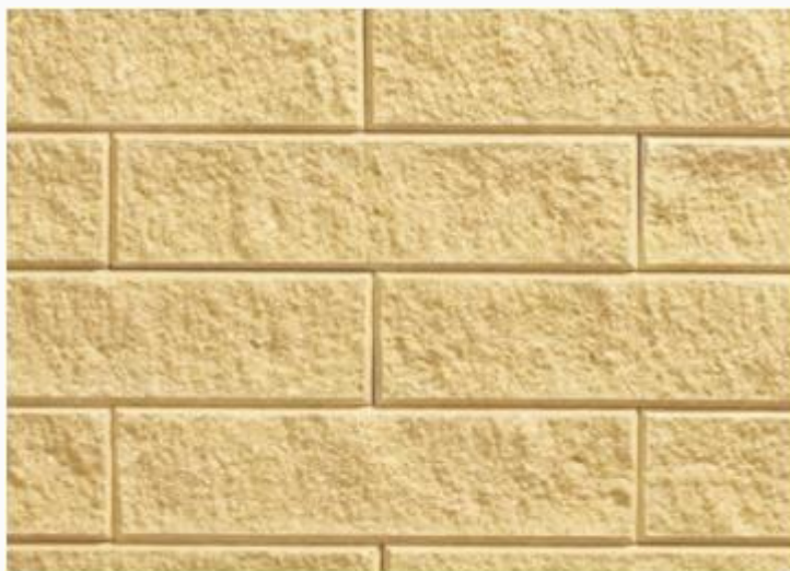
Бесшовная укладка плитки
