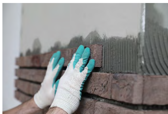
Укладка плоских клинкерных плиток с помощью шнура.
